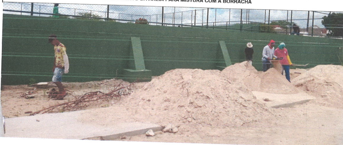
PENEIRAMENTO DA AREIA PARA MISTURA COM A BORRACHA
